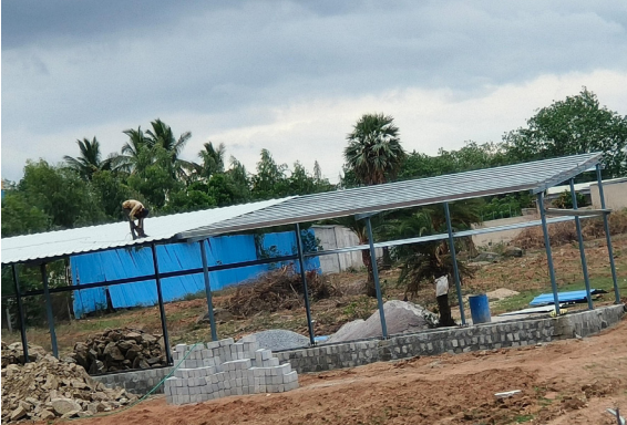
గౌరెల్ గ్రామంలో వ్యవసాయ భూమి లో షెడ్ నిర్మాణం
